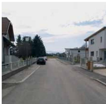
Eine 3 cm dicke Verschleisschicht samt Regenwassereinläufen und Gehsteig wurde in Mühling in der Bahnstraße verwirklicht.
