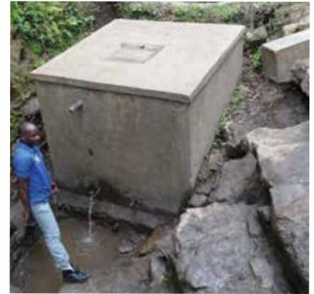
Wasserbasin mit Sandfilter: Wenn es möglich ist, versucht der Verein bei der Wasserversorgung zu helfen. Verschmutztes Wasser aus einem Tümpel wird durch einen Sandfilter geleitet und in einem Basin gesammelt. Die Menschen können dann für sie trinkbares Wasser entnehmen.
