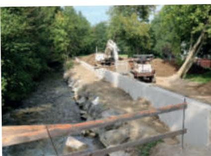
Hochwasserschutzmauer schützt Einzelobjekte in Haag vor Überschwemmungen des Mühlbaches
