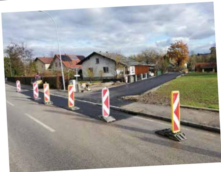
Weinzierl-Riedgasse: Steinwurferrichtung für Hangsicherung, Oberflächenwasserentsorgung, Wasserleitungssanierung, Straßenbeleuchtungspunkte, LWL-Leerverrohrung, Straßenverbreiterung auf 6 m und Asphaltierung der Siedlungsstraße
