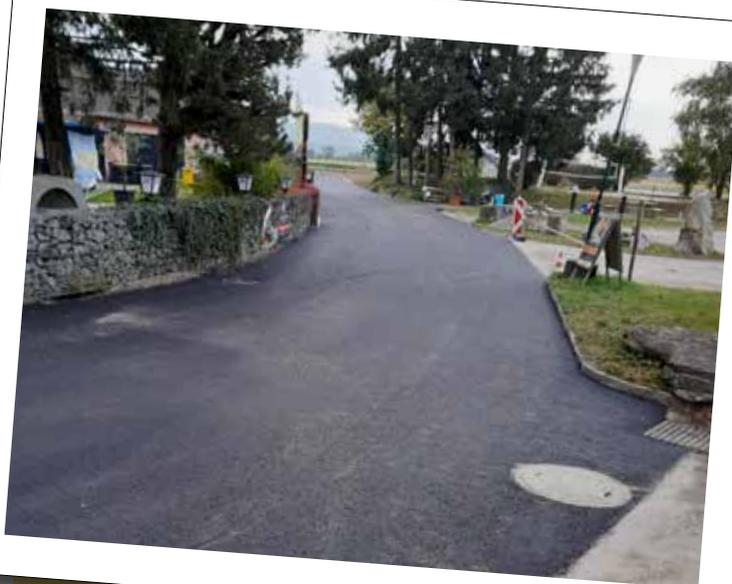
Bodensdorf: Lichtpunkt, Breitbandleerverrohrung, Einlaufgitterschächte, Unterbauplanum, Frostschuttschicht, Tragschicht, Asphaltdecke, Wasserhausanschlüsse
